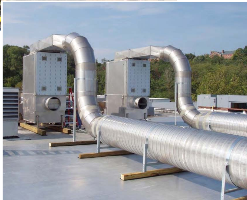
Después de la instalación
