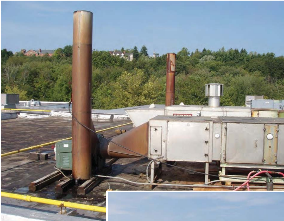
Antes de la instalación
